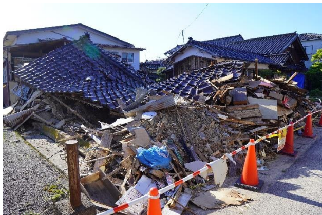
正院町近隣における古い木造家屋の倒壊（左）と傾斜（右：正面側に大きなガラス戸）
