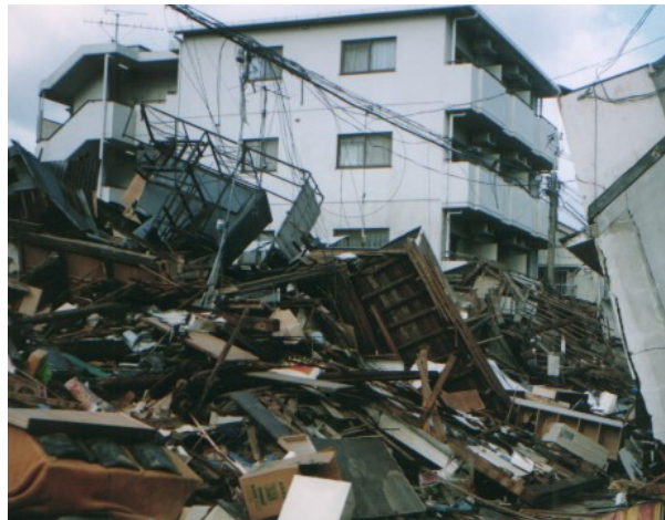
地震による揺れで被害を受けた住宅（地域不明） （出典）気象庁ウェブサイト
