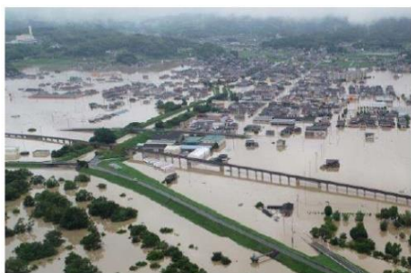
高梁川水系小田川の氾濫状況 (岡山県倉敷市真備町)
