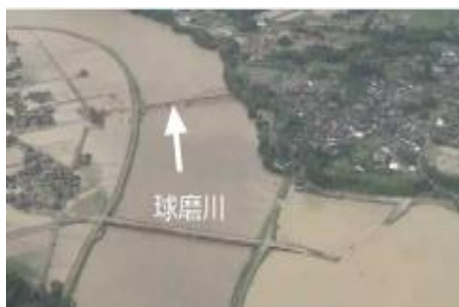
球磨川の氾濫状況 (熊本県人吉市)
