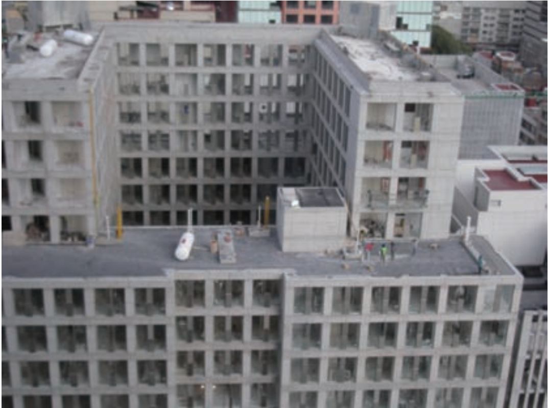
メキシコ市内旧市街・歴史地区建築中ビル
