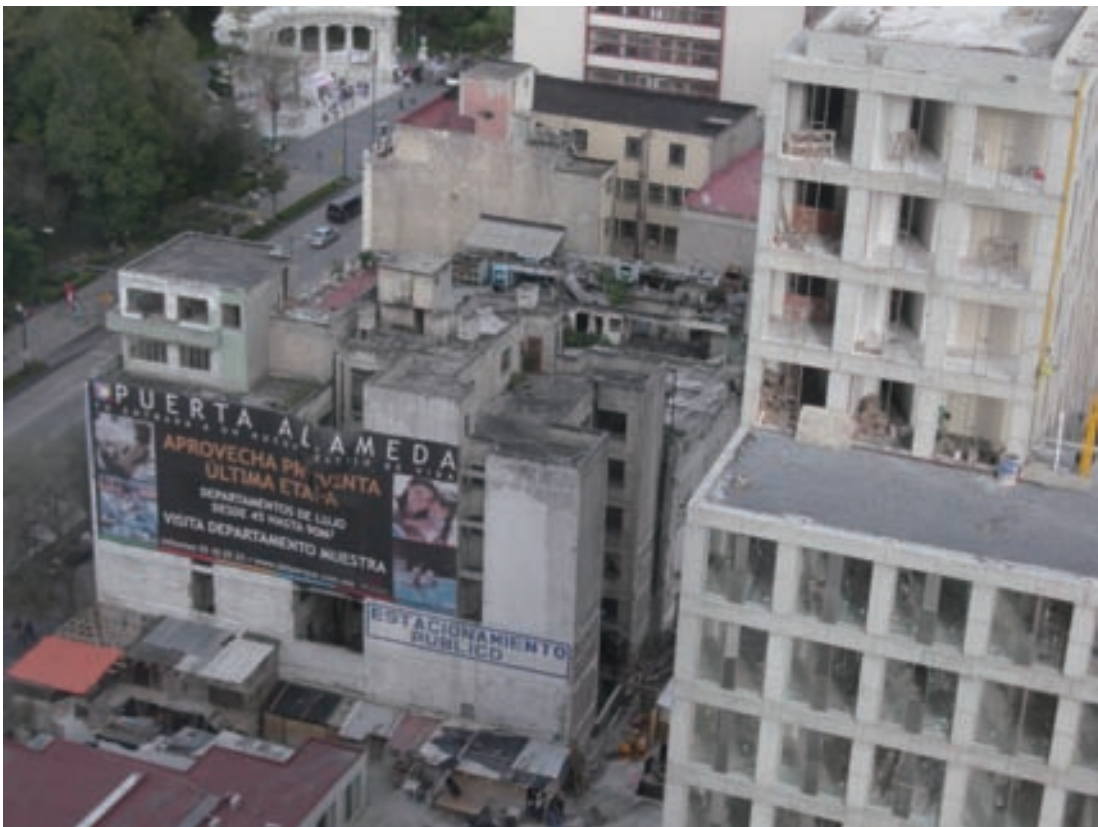
メキシコ市内旧市街老朽ビル
