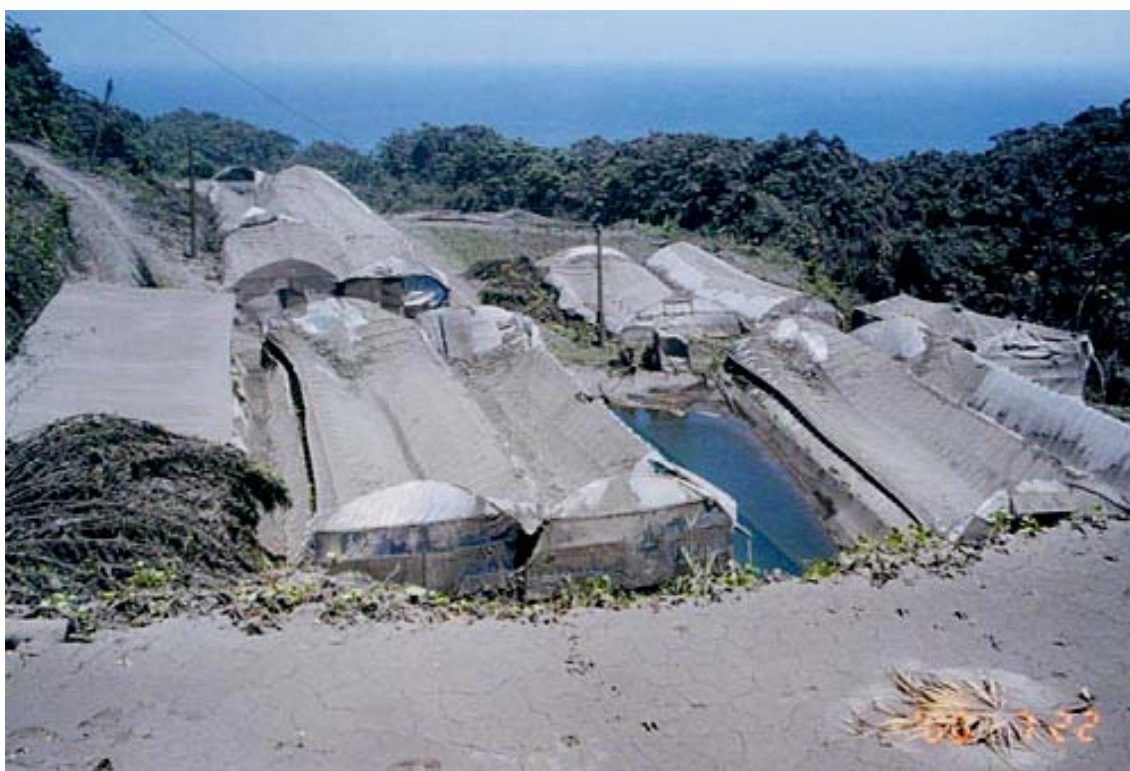
〔写真1〕 三宅島2000年噴火 降灰の重さで潰れたビニールハウス (撮影：アジア航測(株)千葉達朗氏)
