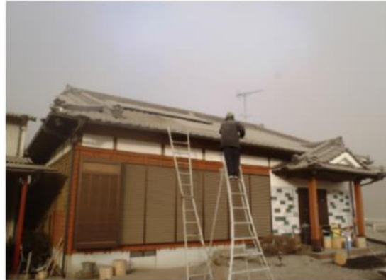
屋根に積もった火山灰を除去する住民
