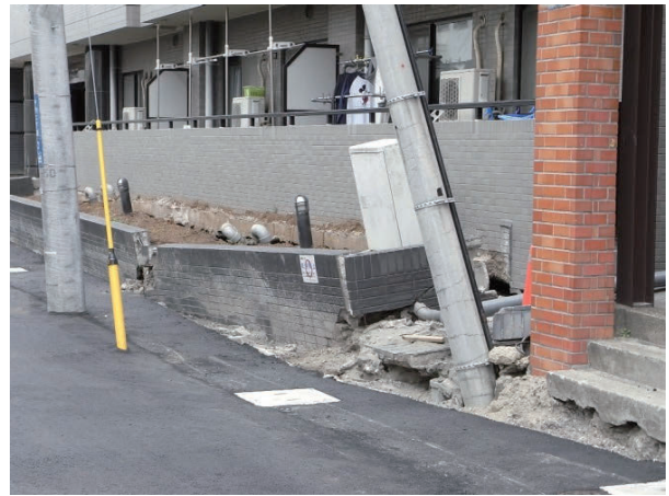
東北地方太平洋沖地震の液状化被害
