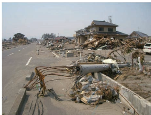
東北地方太平洋沖地震の津波被害
