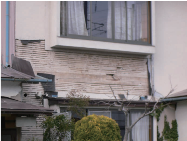
東北地方太平洋沖地震の損壊被害
