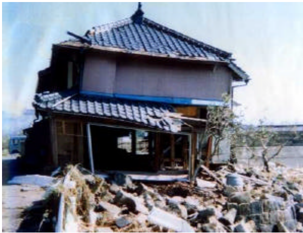
写真 2.3.3 高潮で全壊した住家（不知火町役場提供） 不知火町松合地区
