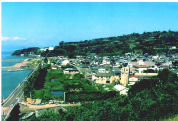
写真 2.3.1 罹災前の松合地区 (不知火町役場提供)
