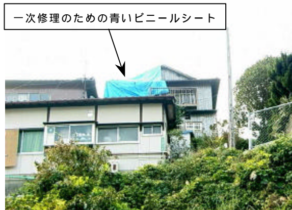
写真4.2.1 屋根瓦が飛散した家屋(1) (高台に立地する家屋/下関市後田付近)
