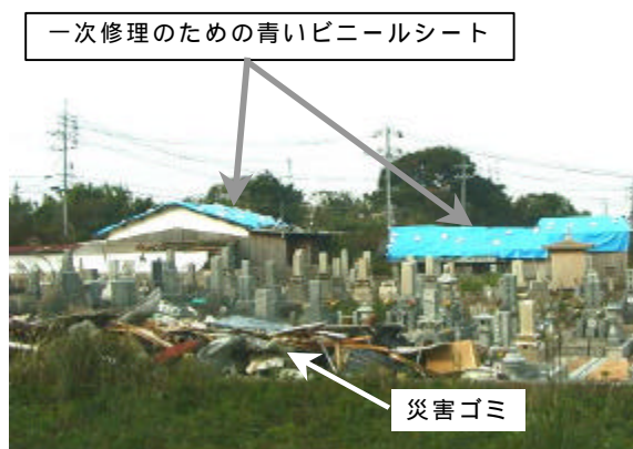
写真4.4.1 竜巻により屋根瓦が飛散した家屋と災害ゴミ(小野田市叶松付近)
