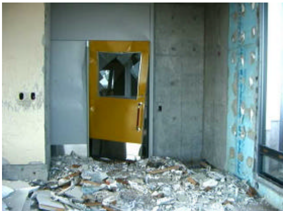
写真4.3.1 高潮により半壊した海岸沿いの福祉施設内部の様子(宇部市常盤地区)
