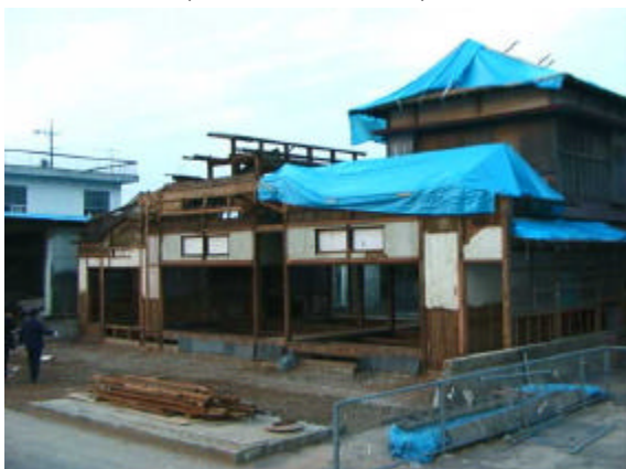
写真4.3.3 高潮により全壊した海岸沿いの建物～手前側から高潮が襲来～(山陽町埴生地区)
