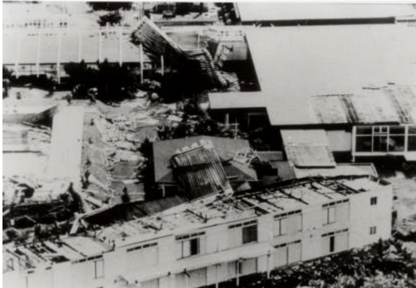
図 - 3 折板屋根の被害 (日本建築学会：1975年台風13号による八丈島の建物被害の記録)
