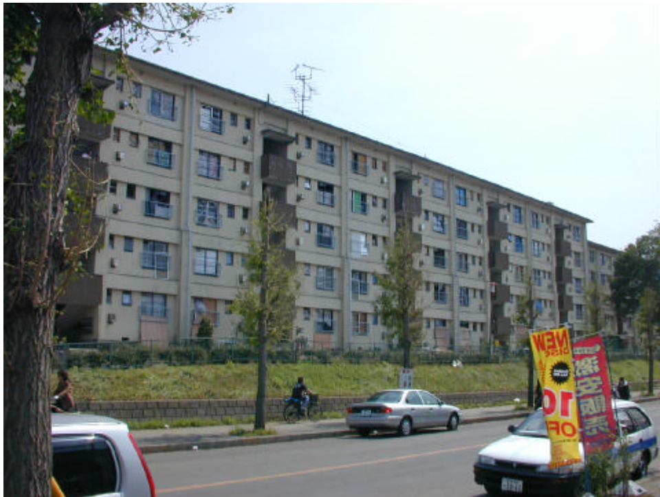
図6 団地北面の被害（我孫子市湖北台） 被害の2日後に撮影した。北側の窓ガラスのほとんどが破損した。
