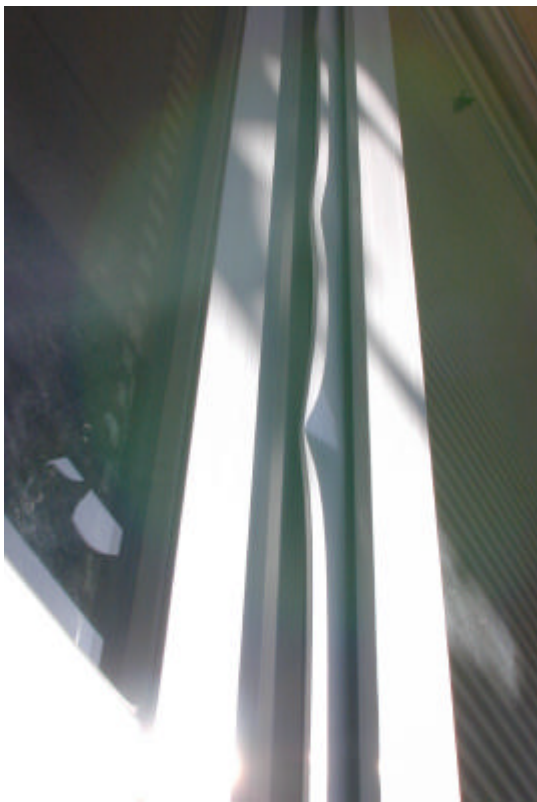
図 7 校舎のアルミサッシの被害(取手市内)
