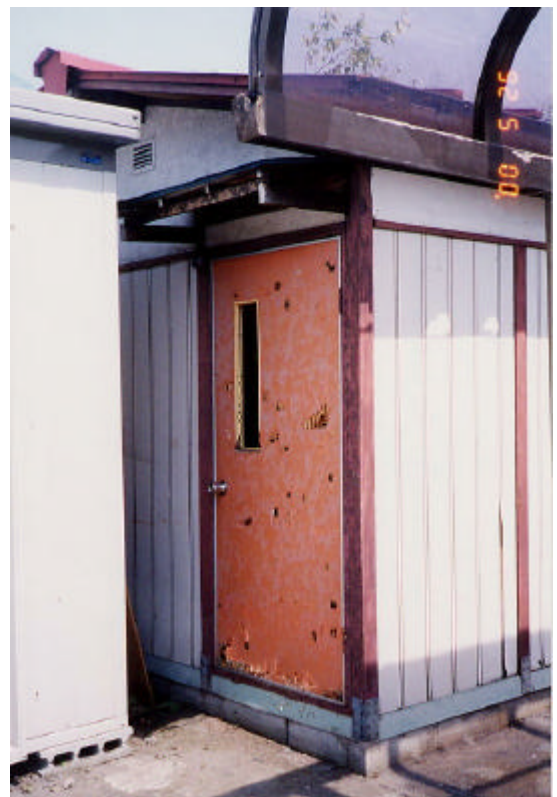
図 8 物置扉の被害(我孫子市内)
