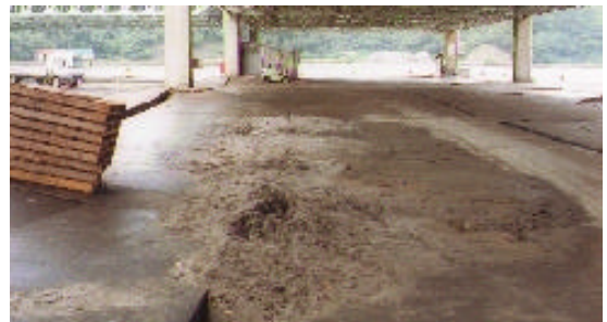
写真 22 昭和北埠頭（かにかご岸壁）。液状化による噴砂。
