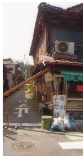
写真 15 「危険」判定建物。 1 階部分が傾斜。
