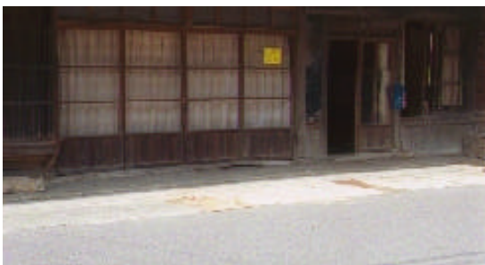
写真 08 応急危険度判定「要注意」建物
