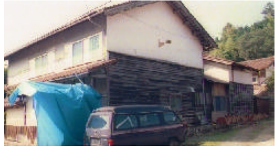
写真 06 屋根瓦の損壊と漆喰の剥落
