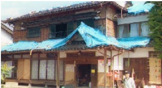
写真 13 「要注意」判定建物。屋根瓦損壊、漆喰剥落。
