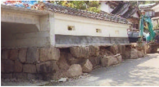
写真 11 石塀の組基礎破壊
