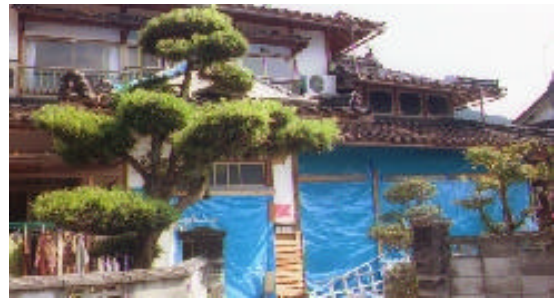
写真 14 「危険」判定建物。屋根瓦損壊、壁の剥落。
