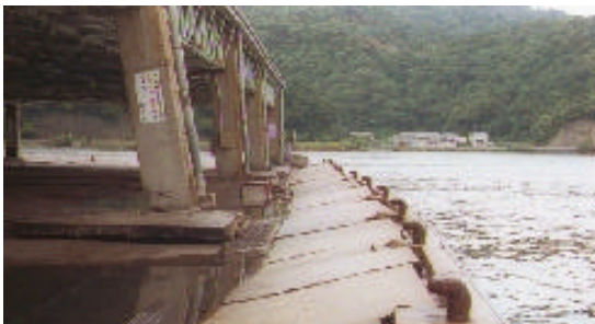
写真 21 昭和北埠頭（かにかご岸壁）。支柱の傾斜、地盤の陥没。
