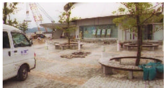
写真 23 竹内団地南側「境港さかなセンター」横。タイルの浮き上がり。
