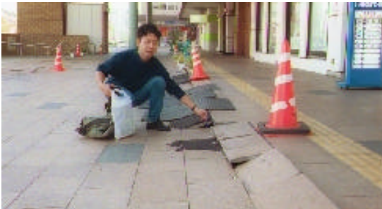
写真01 JR米子駅。歩道の地盤沈下が見られた。
