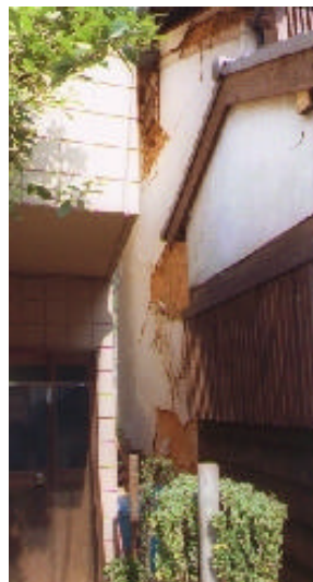
写真 07 漆喰の剥落
