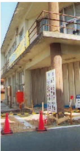
写真03 溝口町役場(RC造) 応急危険度判定で「危険」建物とされ、立ち入り禁止となっている。隣接する公民館に機能を移転し、今回の地震の対応をしていた。
