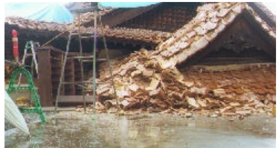
写真 20 出雲大社上道教会。建物前部の崩壊。
