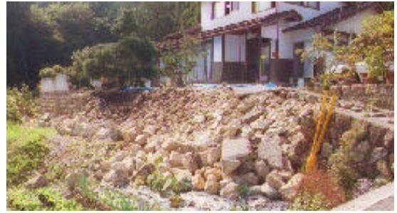
写真 12 石組みの擁壁崩壊
