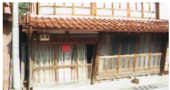
写真 17 「危険」判定建物。1 階部分が傾斜。
