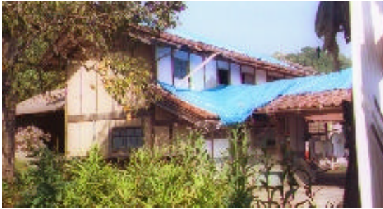
写真 05 屋根瓦の損壊。溝口町の集落、三部(さんぶ)では一部壊ないし半壊の建物が半数程度あった。屋根瓦の損壊が主な被害である。
