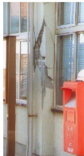
写真04 溝口町役場。柱のせん断破壊が見られる。
