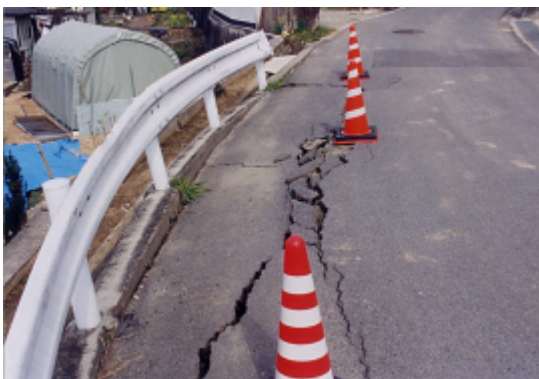
写真5 道路の亀裂。写真左側は崖になっており、その石垣が緩んで被害が生じている。
