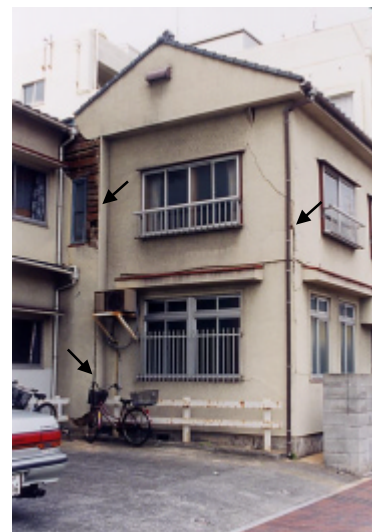
写真9 外壁の剥離と亀裂。
