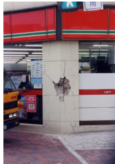
写真8 外壁の損傷。市街の中心部では外壁の亀裂あるいは剥離などの被害が見られた。
