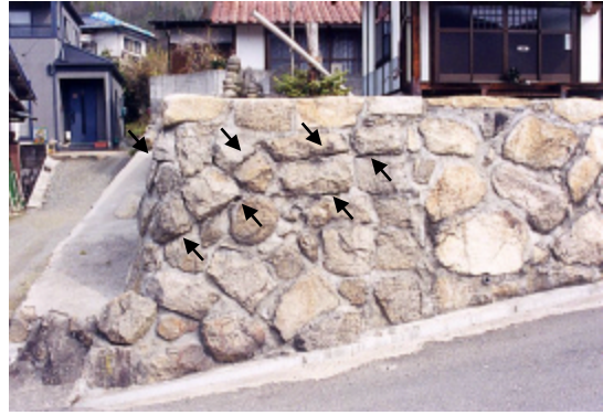
写真3 石垣の被害（矢印の部位）。斜面に住宅を建設するため、宅地の谷側は石垣が組み立てられており、亀裂などの被害が多く見られた。
