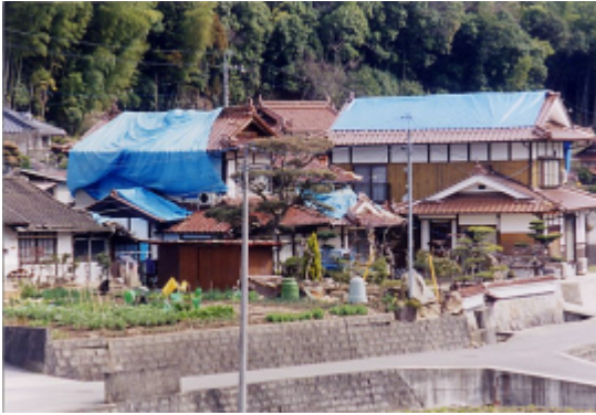
写真2 山すその斜面に宅地を造成して、建てられた住宅が多い。屋根瓦が落下し、ビニールシートをかけている建物が多く見られた。
