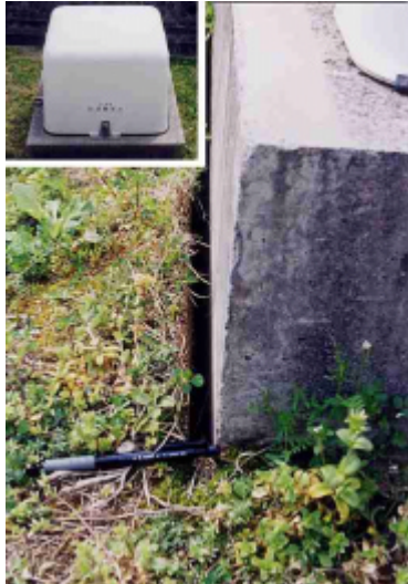
写真7 河内町役場に設置された計測震度計。今回の地震で最大の震度6弱を観測した。基礎と地盤との間に2cm程度の隙間があり、計測震度に何らかの影響を与えた可能性がある。
