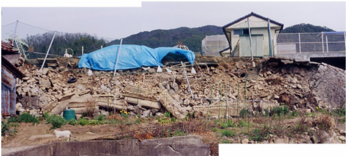
写真4 河内小学校グラウンドの擁壁崩壊。石垣が完全に崩れ、グラウンド上面にも数条の亀裂が生じていた。雨による二次災害を防ぐためにビニールシートがかけられている。
