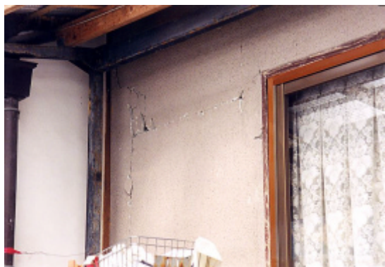
写真6 住宅外壁への亀裂。倒壊に至るまでの被害は見られなかった。
