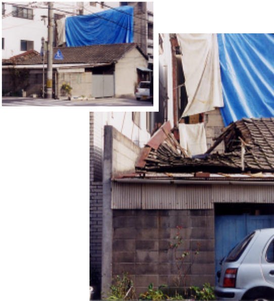
写真11 死亡事故の発生現場。隣接する建物の外壁が屋根を突き破って落下し、その下敷きとなった。
