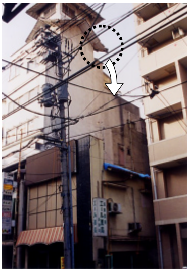
写真12 落下した屋根瓦が、隣の建物の1Fまで達した。市街地では壁あるいは屋根瓦の剥落によって、隣の建物に被害をおよぼすケースが見られた。
