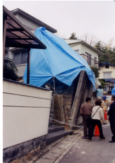
写真17 西区己斐上、明山台団地。石垣・塀の被害。
