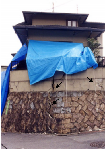
写真15 西区己斐上、明山台団地。石垣・塀の被害。建物そのものには被害が少ないが、斜面に造成された宅地に被害が多く見られた。余震や降雨などによる二次災害が懸念される。
