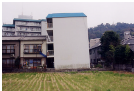
写真18 東区牛田早稲田における4階建マンション。不等沈下によって建物全体が数度傾斜している。広島市の被害判定で半壊とされた建物のうちのひとつ。周囲の建物に外見上の被害は見られない。
