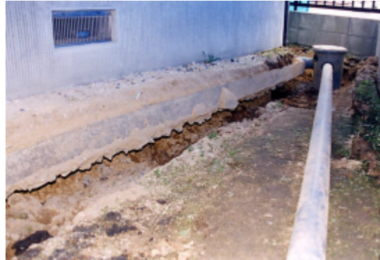
写真16 西区己斐上、明山台団地。写真15の住宅の敷地内。石垣が緩むことによって、数十cm地盤沈下している。建物所有者の話によると建物自体には目立った被害はない。
