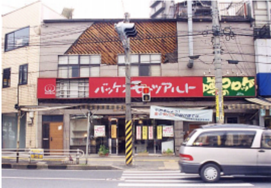
写真13 西区己斐本町、広島電鉄西広島駅付近。外壁の剥落。市街地ではこのほか、塀などに損害が見られたが、建物の構造に影響を与えるような損害は見られなかった。
