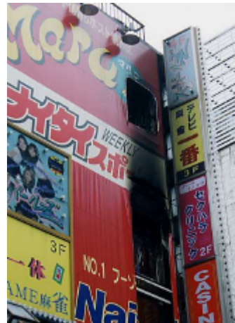
図1 2人飛び降りて逃げた3階の窓 (4階の窓は、消防が救助のため開けた)
