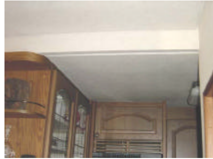
写真2 1階台所の天井、鉄骨梁を使用したため天井が一段低い
