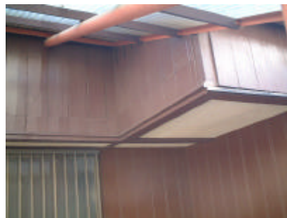
写真4 ガレージ部分の鉄骨
