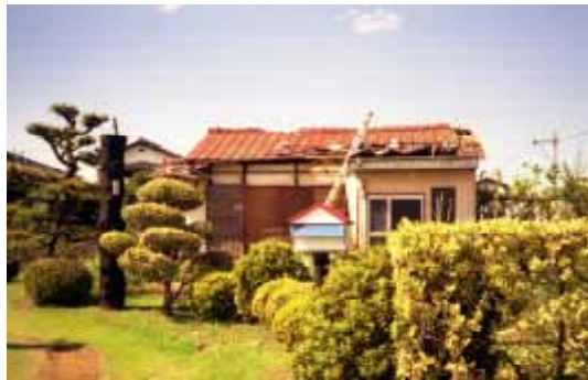
写真 屋根瓦の被害(北米岡地区) の南側周辺の建物は東～南側部分で被害が発生している。(南方向より)
