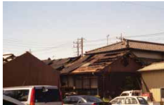
写真 屋根の被害(東町地区) 東～南方向の風で前面建物は屋根材が飛散、後方の住宅は瓦にずれが生じている。(南東方向より)
