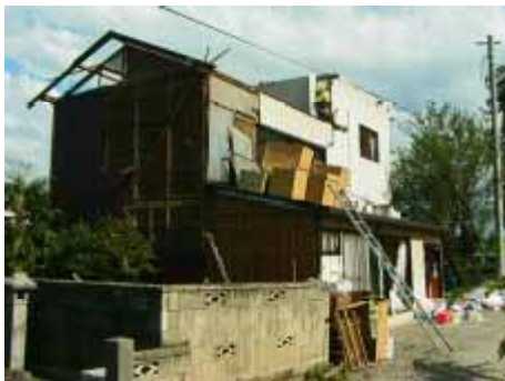
写真 屋根が飛散した住宅(平塚地区) の北西側に位置する。外壁も破損している(北西方向より)
