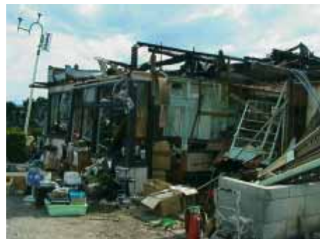
写真 全壊した店舗(平塚地区) 屋根はもちろん、外壁、主要構造部も大破している。(北東方向より)
