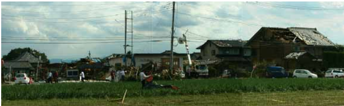
写真 住宅の被害状況(平塚地区) この地区では住家は東～南方向の風で被害を受けている(北東方向より)
