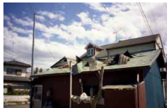
写真 トタン屋根の被害(東町地区) 東方向からの風でトタンが剥離した。(北西方向より)
