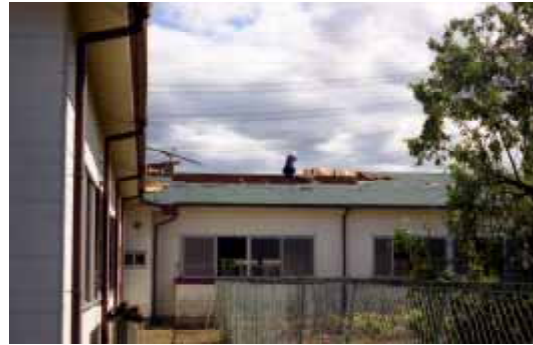
写真 屋根に被害を受けた保育園(北米岡地区) フェンス、樹木は西方向へ倒れている。(北方向より)
