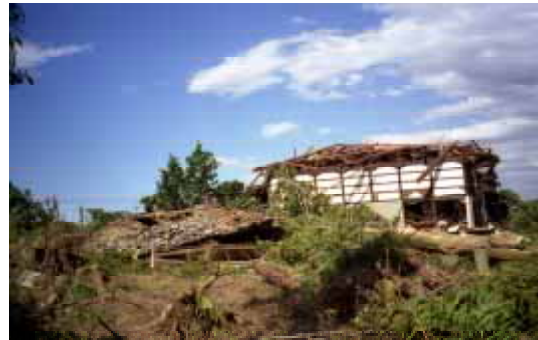
写真 全壊した寺院本堂(平塚地区) 小屋組みは飛散し、骨組みだけが残った。境内の巨木も根本からなぎ倒されている。(西方向より)
