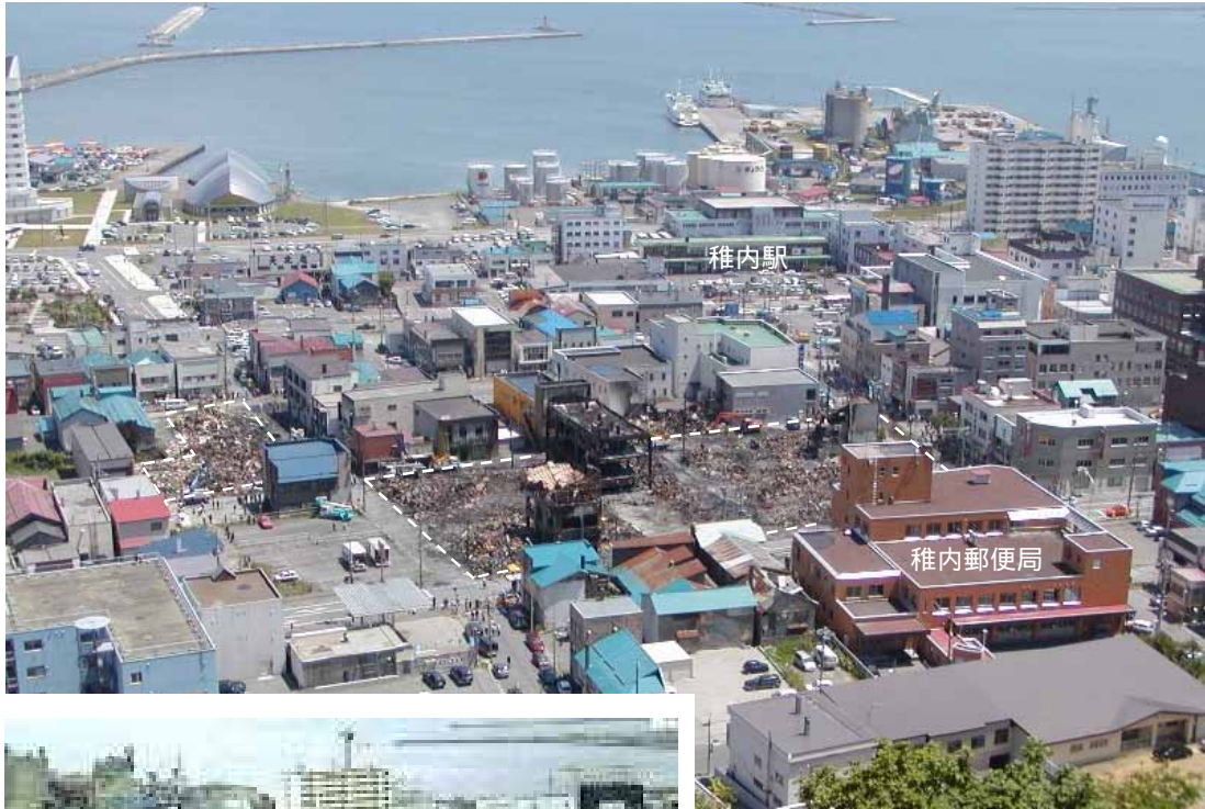
写真 1.1.1 中央地区の被害全景 (右から左へ延焼した。現場には耐火建築の躯体だけが残った。)
