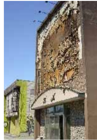
2.3 耐火建築の表面被害被
