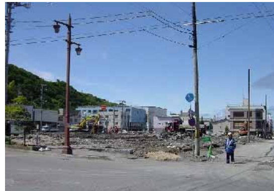
2.5 南東角から北西方面を望む
