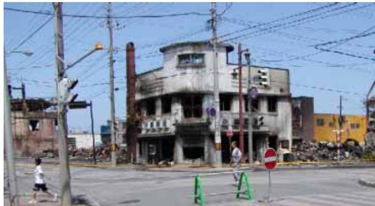
写真 1.2 中央地区 稚内郵便局前の交差点から (中央の後藤薬局は、昭和4年に建築された稚内初の耐火建築で、昭和5年の大火の際に燃え残った建物であったが、今回の大火により被害を受け、取り壊された。)
