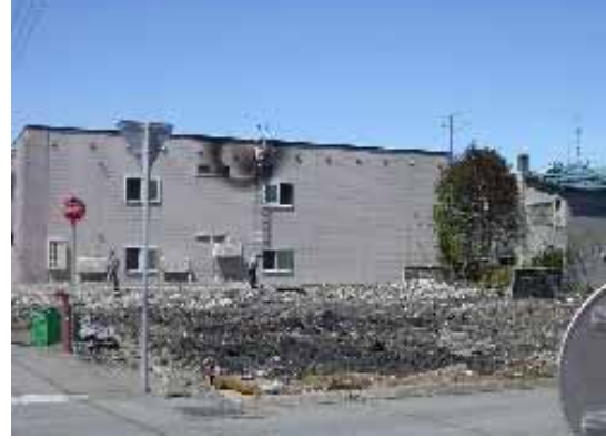
2.2 飛火により延焼した現場
