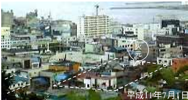
写真 1.1.1 中央地区の被害全景 (右から左へ延焼した。現場には耐火建築の躯体だけが残った。)
