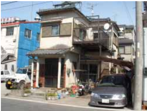
写真2.2.1a サンプル建物例 (西区左岸：浸水位160cm)
