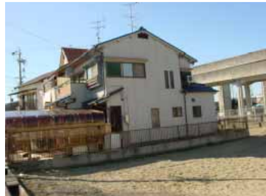
写真2.2.1b サンプル建物例 (西区右岸：浸水位100cm)
